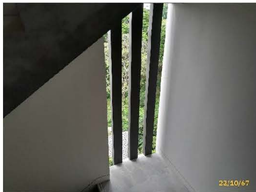
ระบบระบายอากาศของบันไดหนีไฟ (อาคารพักอาศัย)
